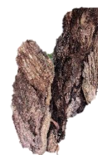
Foto 11: Madera dañada por comején.
